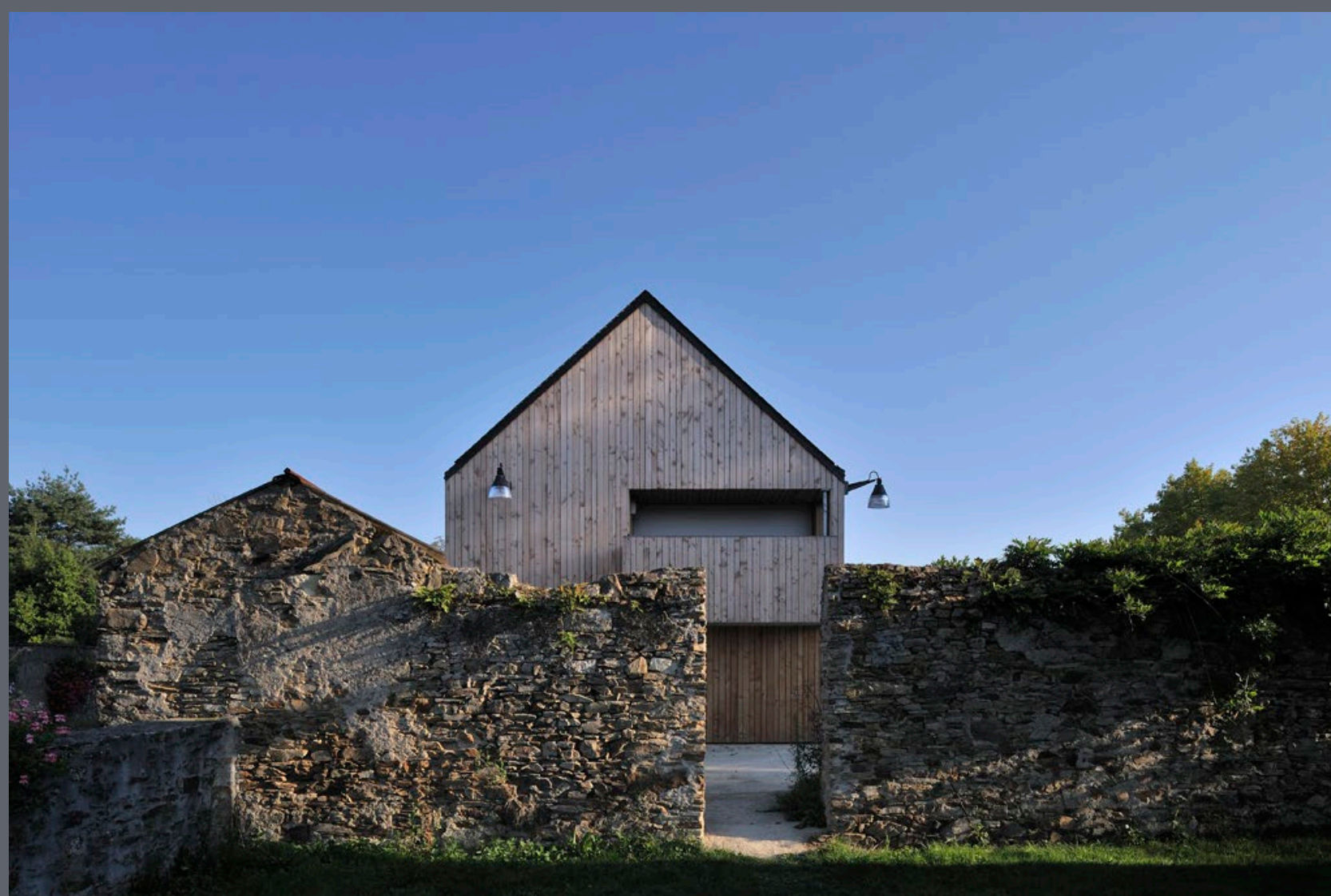
Bouvron - Le Courtil Saint Mathurin - Logements - Garot - Boixel, architectes
