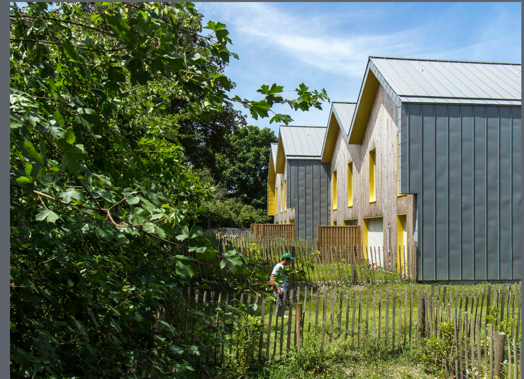
Les Touches - Logements - Urbanmakers, architectes - Zéphyr, paysagistes
