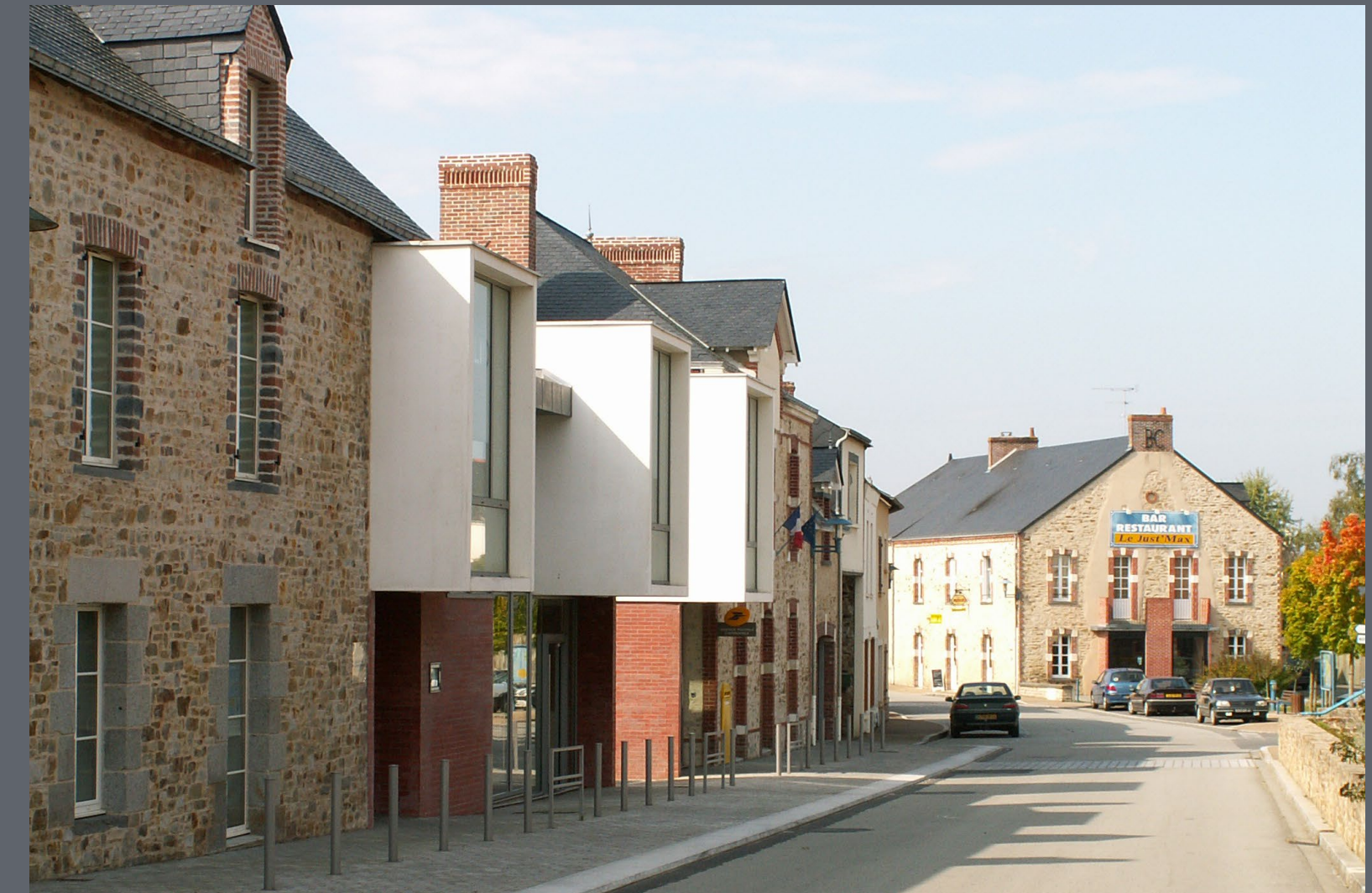
Villepot - Mairie, bibliothèque, accueil périscolaire - Haumont - Rattier, architectes
