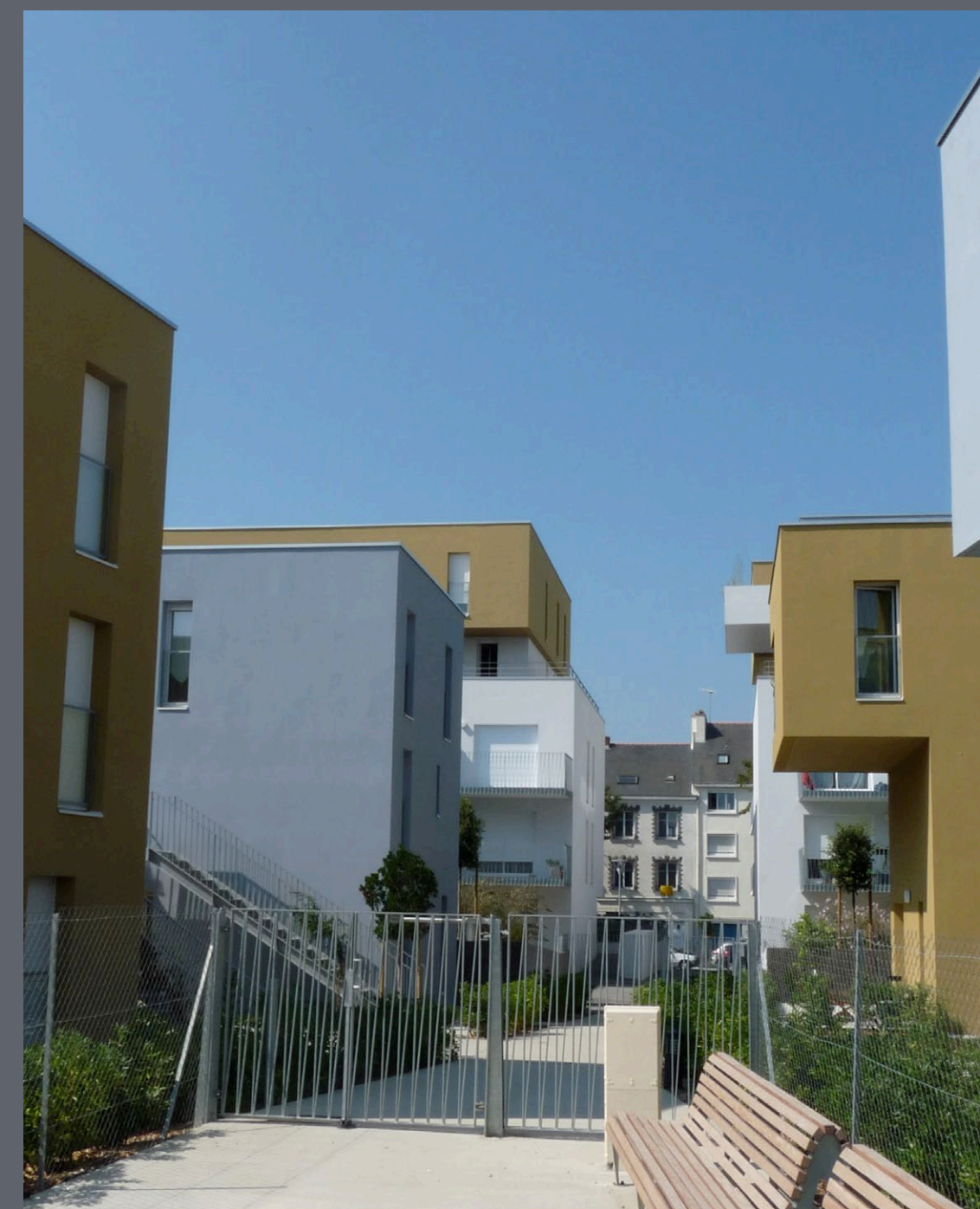
Saint-Nazaire - Logements - Barré - Lambot, architectes
