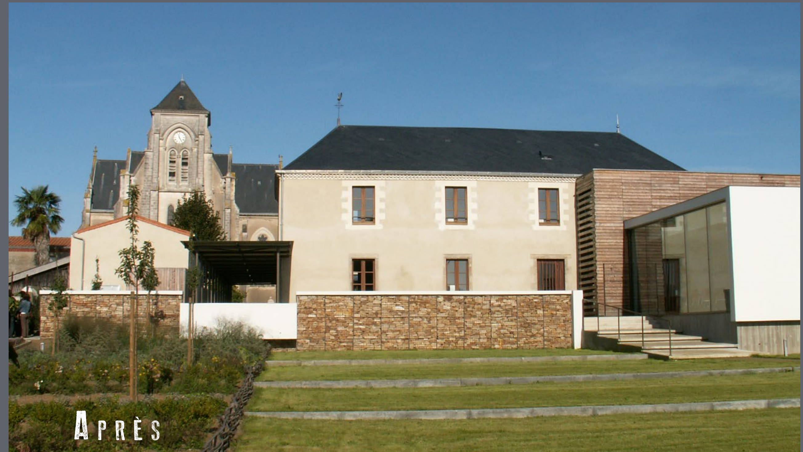
La Planche - Mairie - Jacques Boucheton, architecte
