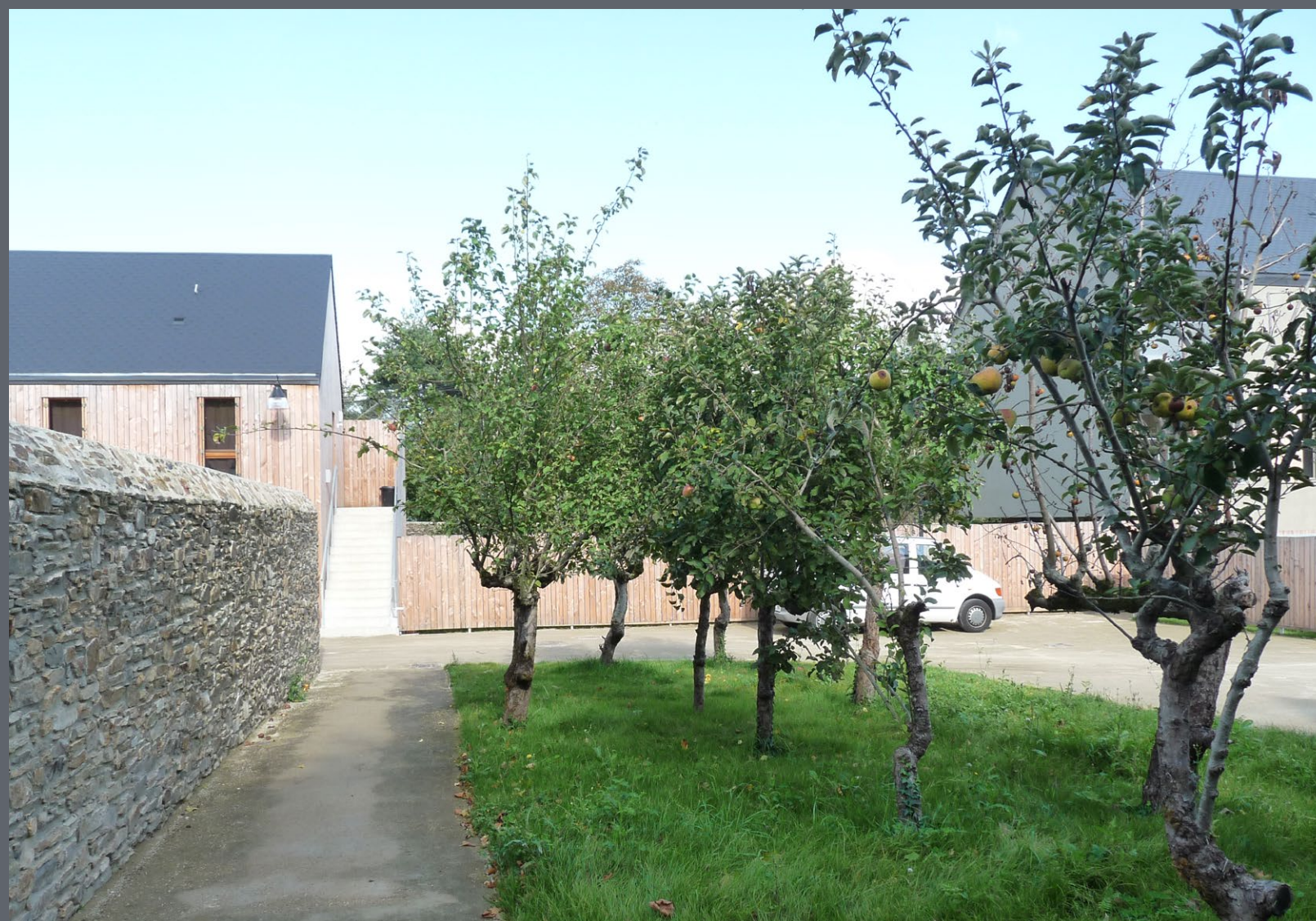
Bouvron - Le Courtil Saint Mathurin - Logements - Garo - Boixel, architectes
