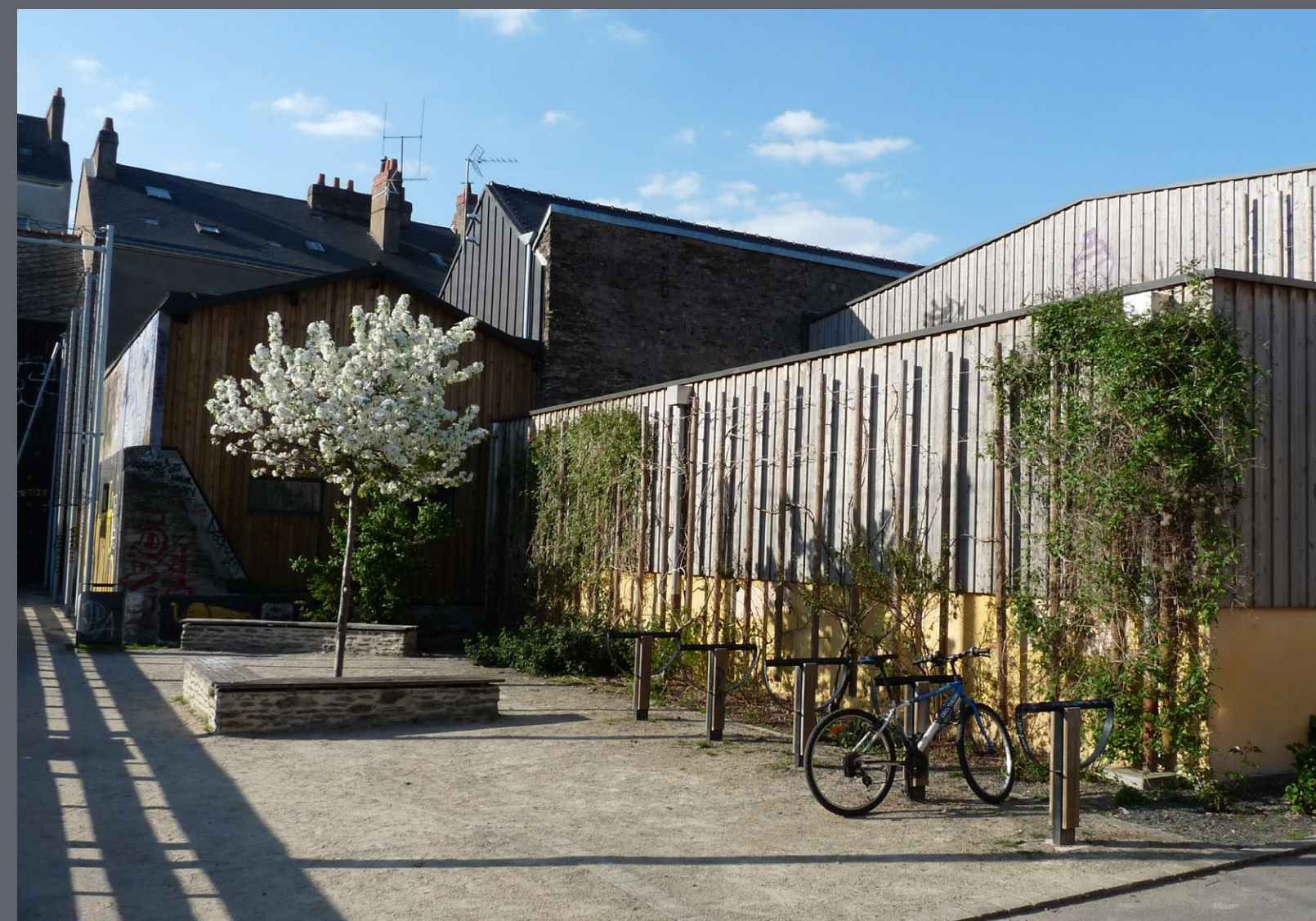
Nantes, Madeleine-Champs-de-Mars, Maison de quartier, Direction BATI de la ville de Nantes
