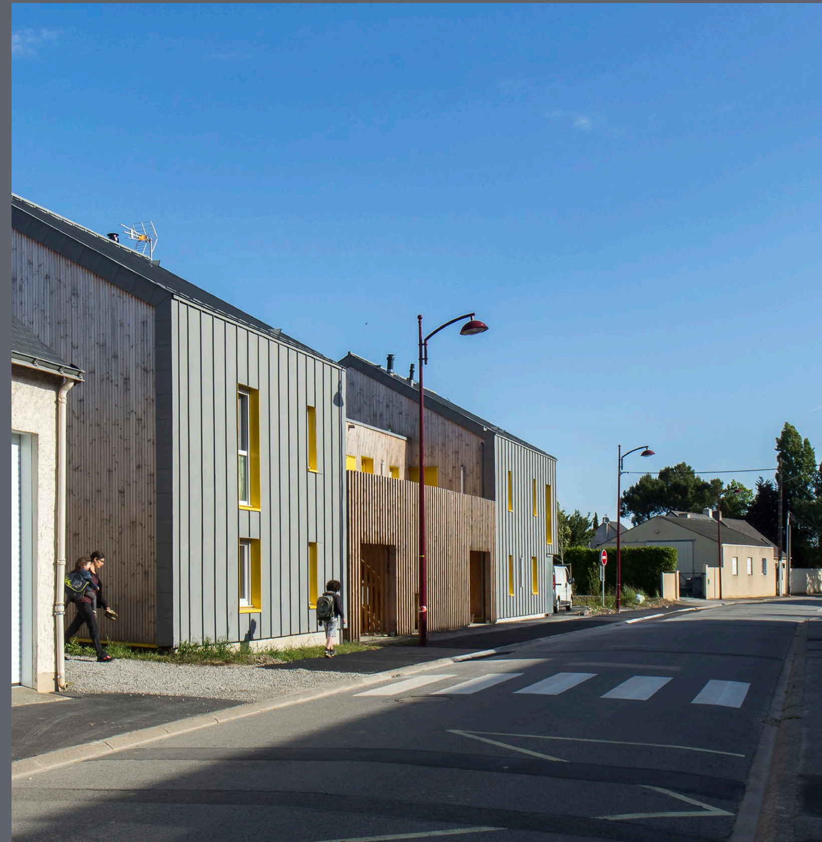
Les Touches - Logements - Urbanmakers, architectes - Zéphyr, paysagistes
